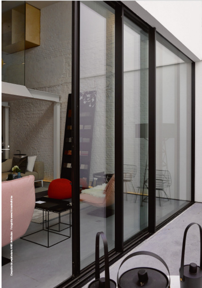
Marco oculto tras el muro y empotrado en el suelo
